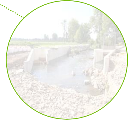
Fischaufstiegsanlage an der Rohrburger Mühle
