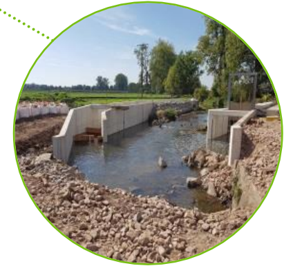
Fischaufstiegsanlage an der Rohrburger Mühle
