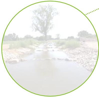
Fischaufstiegsanlage an der Schutterzeller Mühle
