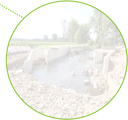
Fischaufstiegsanlage an der Rohrburger Mühle
