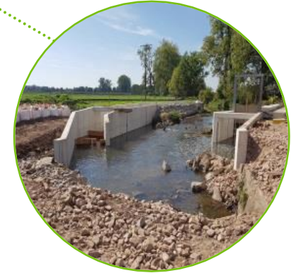
Fischaufstiegsanlage an der Rohrburger Mühle
