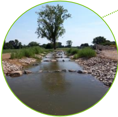
Fischaufstiegsanlage an der Schutterzeller Mühle
