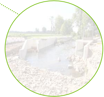
Fischaufstiegsanlage an der Rohrburger Mühle
