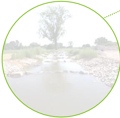
Fischaufstiegsanlage an der Schutterzeller Mühle
