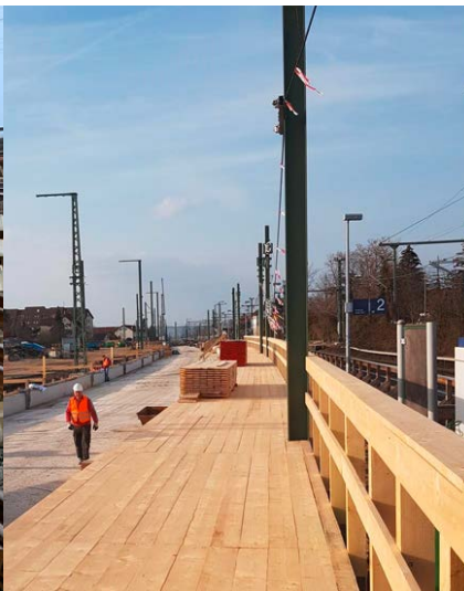
Behelfsbahnsteige am Fußgängersteg in Haltingen
