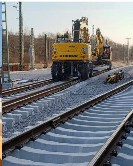
Gleisbauarbeiten südlich des Wasserturms in Weil am Rhein
