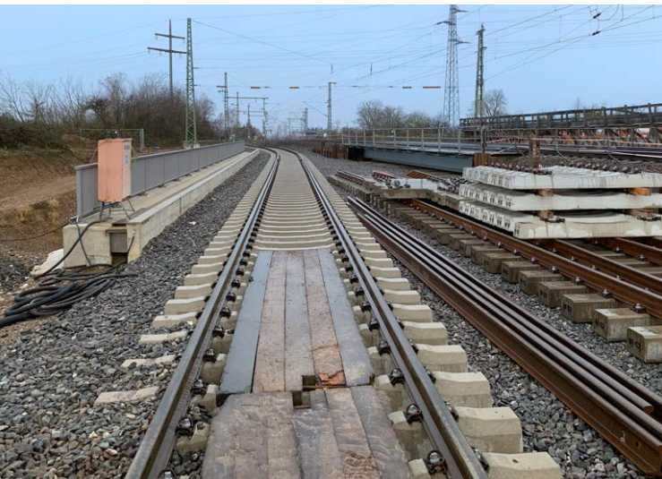
Beginn der westlichen Gleistrasse an der EÜ Nordwestumfahrung (Blick Richtung Norden)
