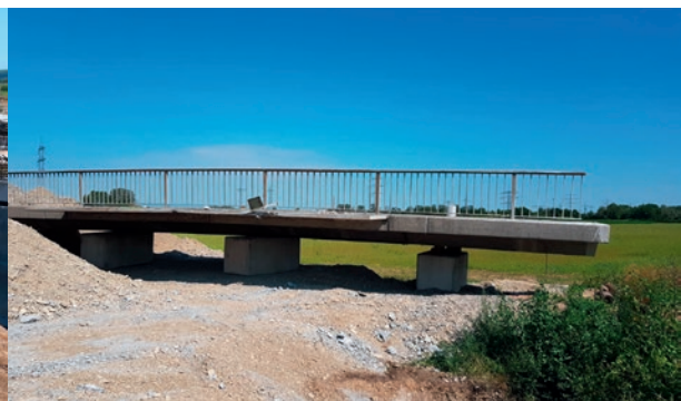
Rückbau der alten SÜ Kleinfeldle
