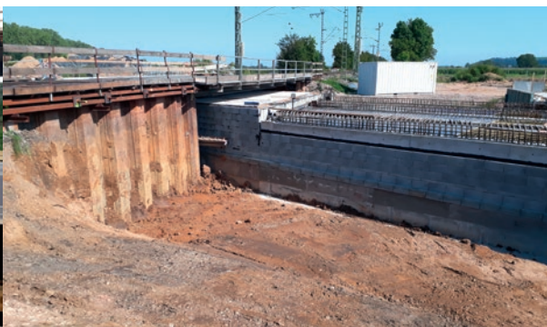
Die neue EÜ Hülzheimer Runs wurde unter die Hilfsbrücken geschoben.
