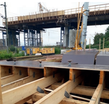
Der Bau der neuen SÜ Fischerpfad ist bereits weit vorangeschritten.
