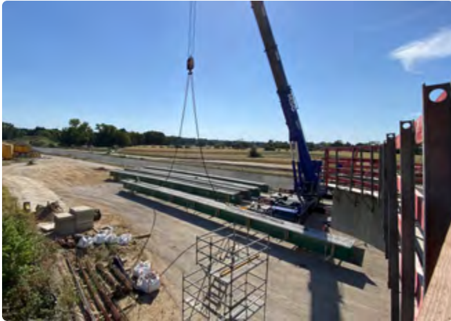
Einheben des Überbaus über die Neubaustrecke
