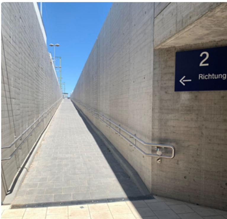
Die Rampen ermöglichen einen barrierefreien Zugang zu den Bahnsteigen.
