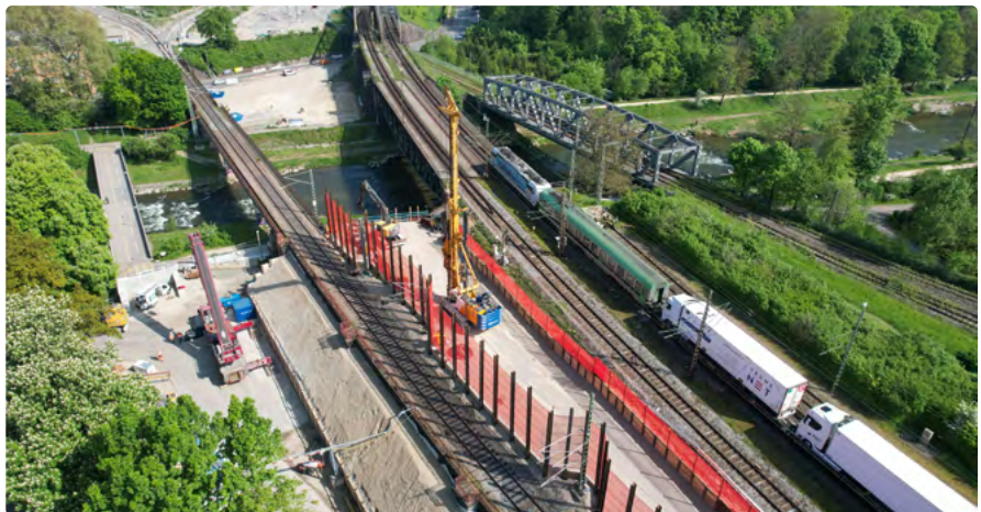
Bauarbeiten an der Eisenbahnbrücke Wiesekorridor
