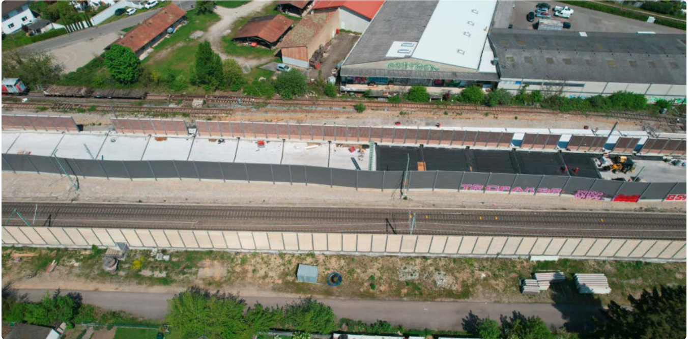
Die Unterschottermatten werden nach Verlegeplänen gefertigt und eingebaut.
