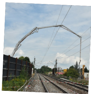
Zur Absicherung wird die östliche Röhre mit Beton verfüllt.
