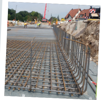
Die Bewehrungsarbeiten werden durchgeführt.
