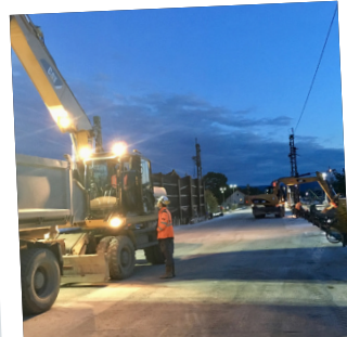
Auf der fertigen Betonplatte werden die neuen Gleise errichtet.
