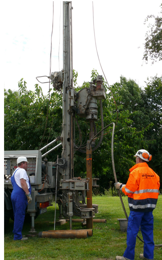
Bohrerkundungen liefern Erkenntnisse über den Boden im Streckenabschnitt 7.
