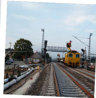
Auch die Oberleitungen werden neu gebaut.
