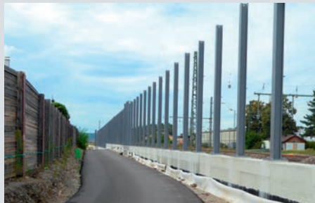
Noch im Bau: die 880 Meter lange Schallschutzwand
