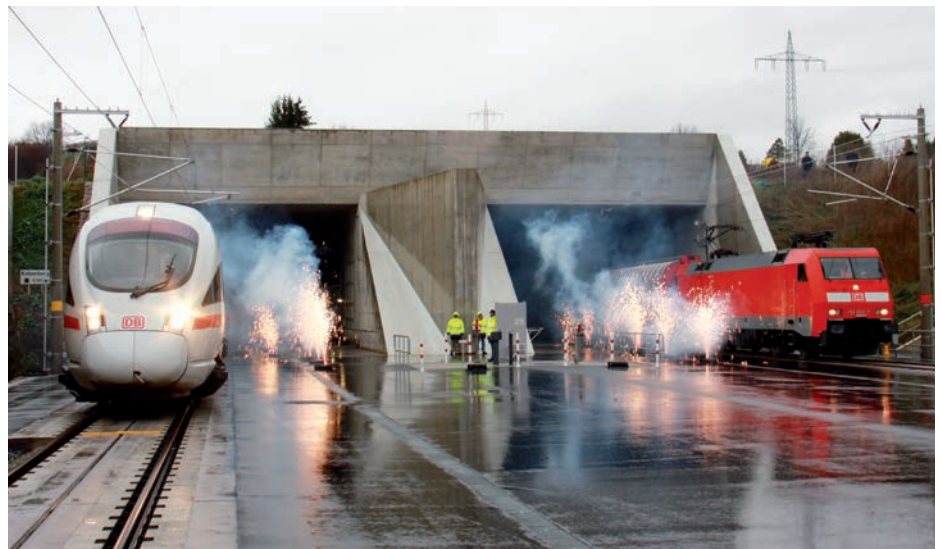
Ankunft der beiden Züge, die den Katzenbergtunnel symbolisch eröffnen, am Südportal
