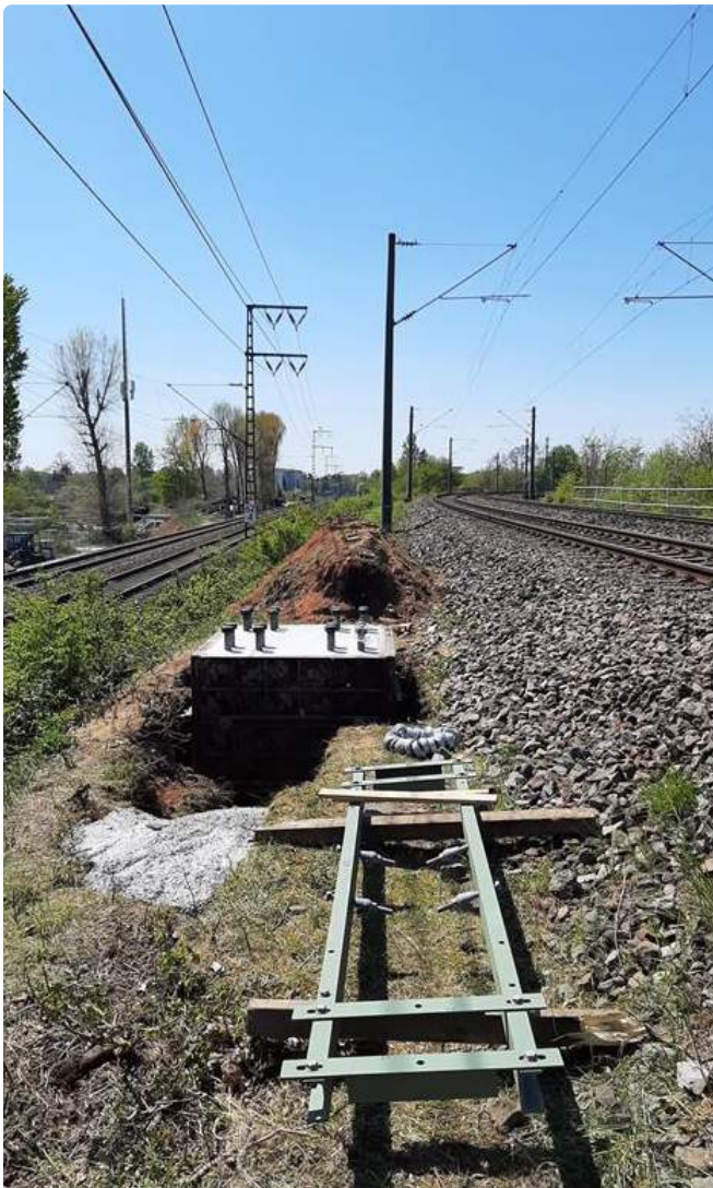
Rückbau der alten Oberleitungsmaste
