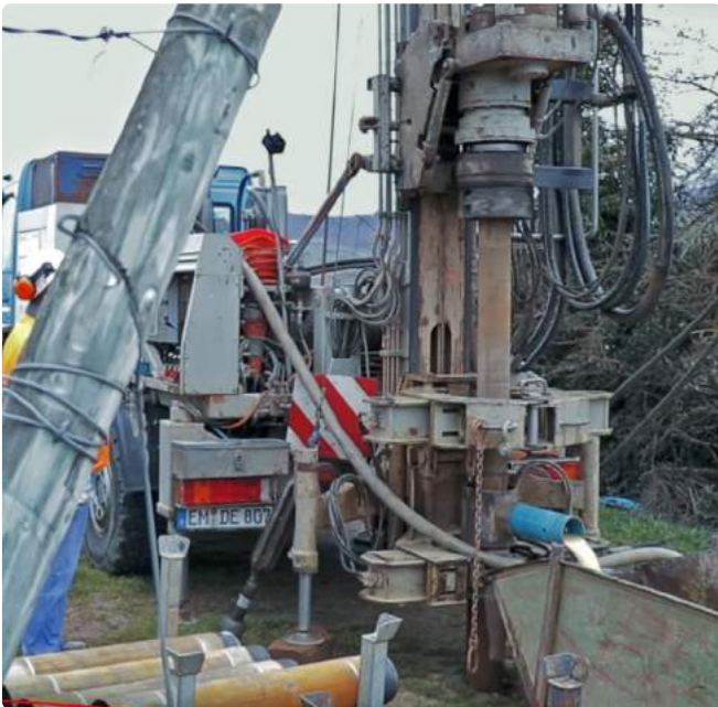
Kernbohrgerät im Einsatz
