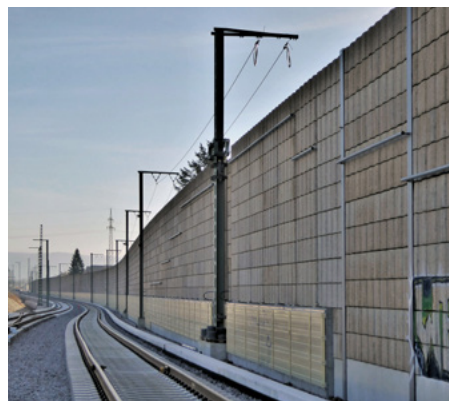
SSW aus Beton in Haltingen.
