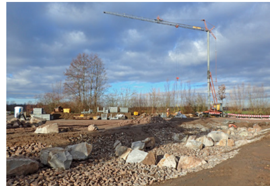
Eingebaute Steinriegel für die naturnah gestaltete Aufstiegsanlage im Flussbett der alten Schutter.
