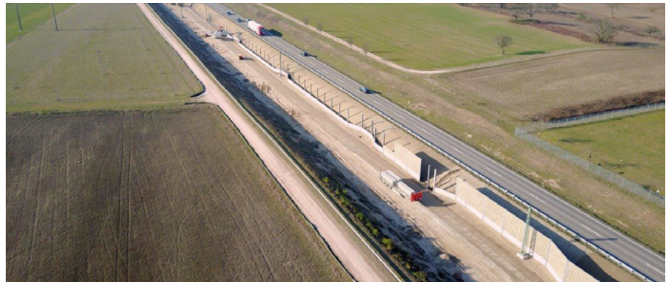
Die Freie Strecke zwischen Bashaide und Ötigheim (Planfeststellungsabschnitt 1.1).
