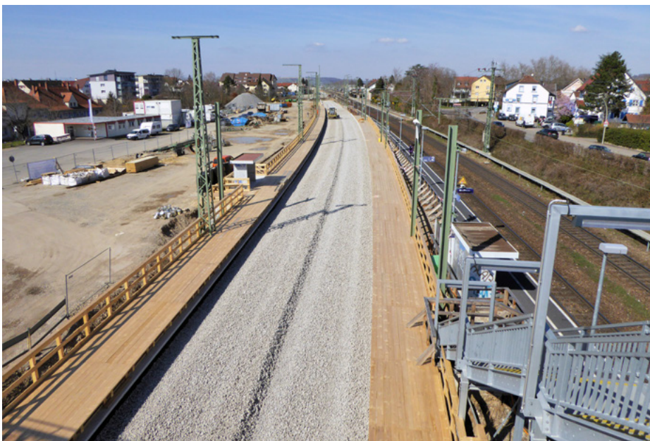
Im südlichen Betontrog in Haltingen liegt schon der Grundsotter.
