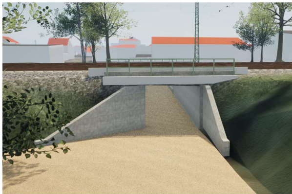
Abbildung 35: PU Bad Krozingen (Bestand)
