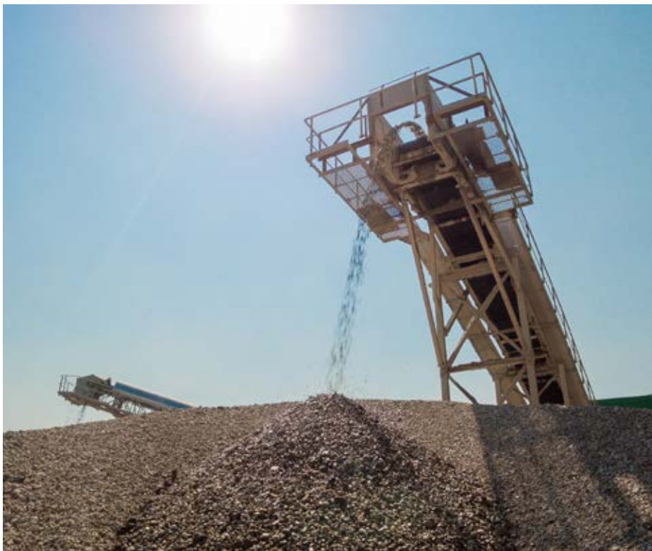
Die Separieranlage trennt die Massen in feste und flüssige Bestandteile.
