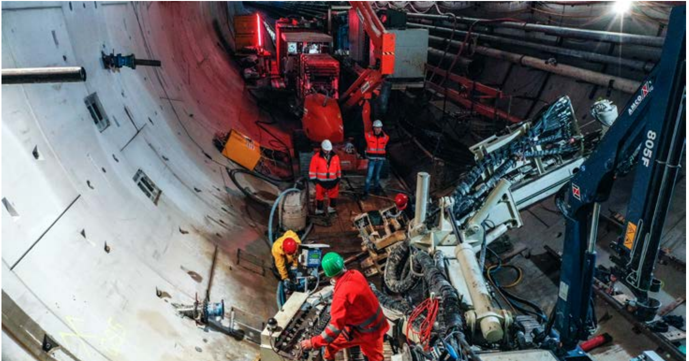
Parallel zum Weiterbau des Tunnels in Niederbühl werden die Querstellen zwischen den Röhren erstellt.
