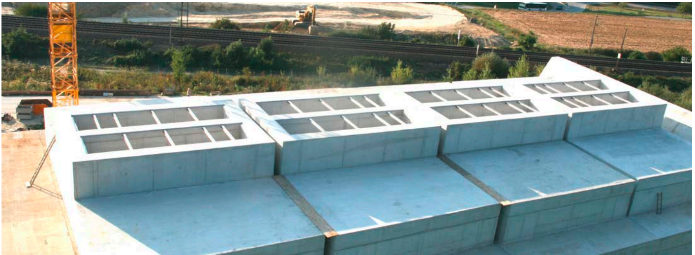
Beispiel für ein Sonic Boom-Bauwerk (hier: Katzenbergtunnel)
