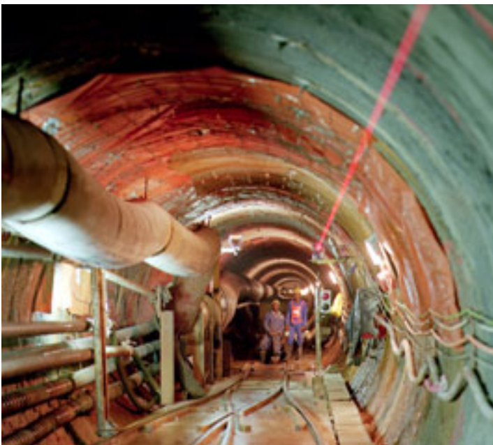
Der Tübbingausbau wird mit einem computergestützten Steuerleitsystem durchgeführt.
