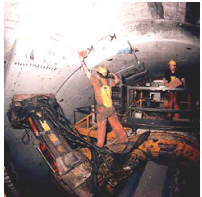
Der hydraulische Teleskoperektor nimmt die Tübbinge auf und versetzt die einzelnen Segmente.
