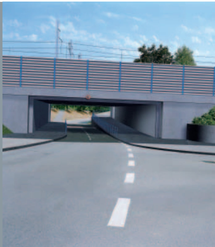
... und künftige Situation (Westseite)
