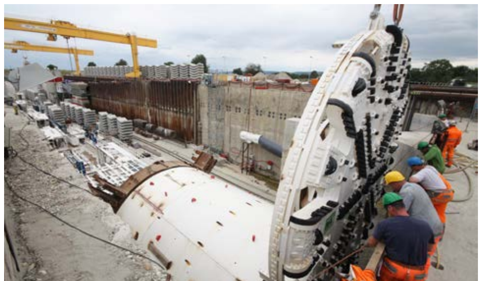
Einheben des Schneidrads an der westlichen TVM „Sibylla-Augusta“
