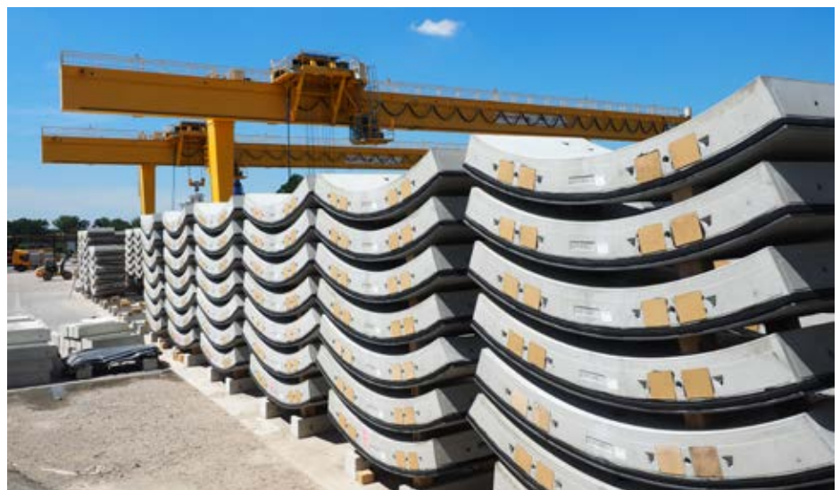
Auf der Baustelleneinrichtungsfläche in Ötigheim warten die Tübbinge auf ihren Einbau.
