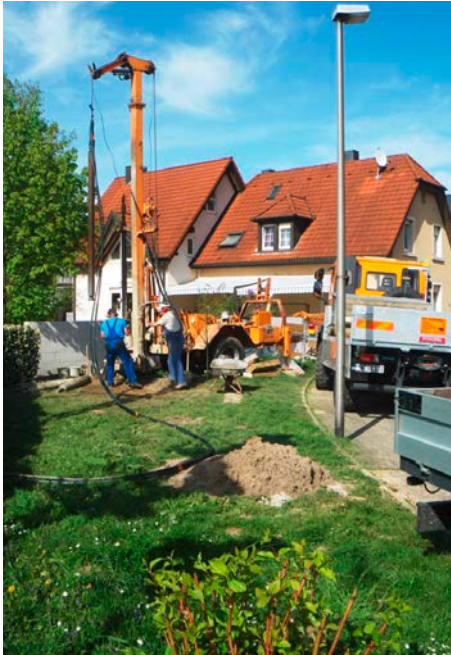
Bohrproben geben Auskunft über die Beschaffenheit des Bodens.
