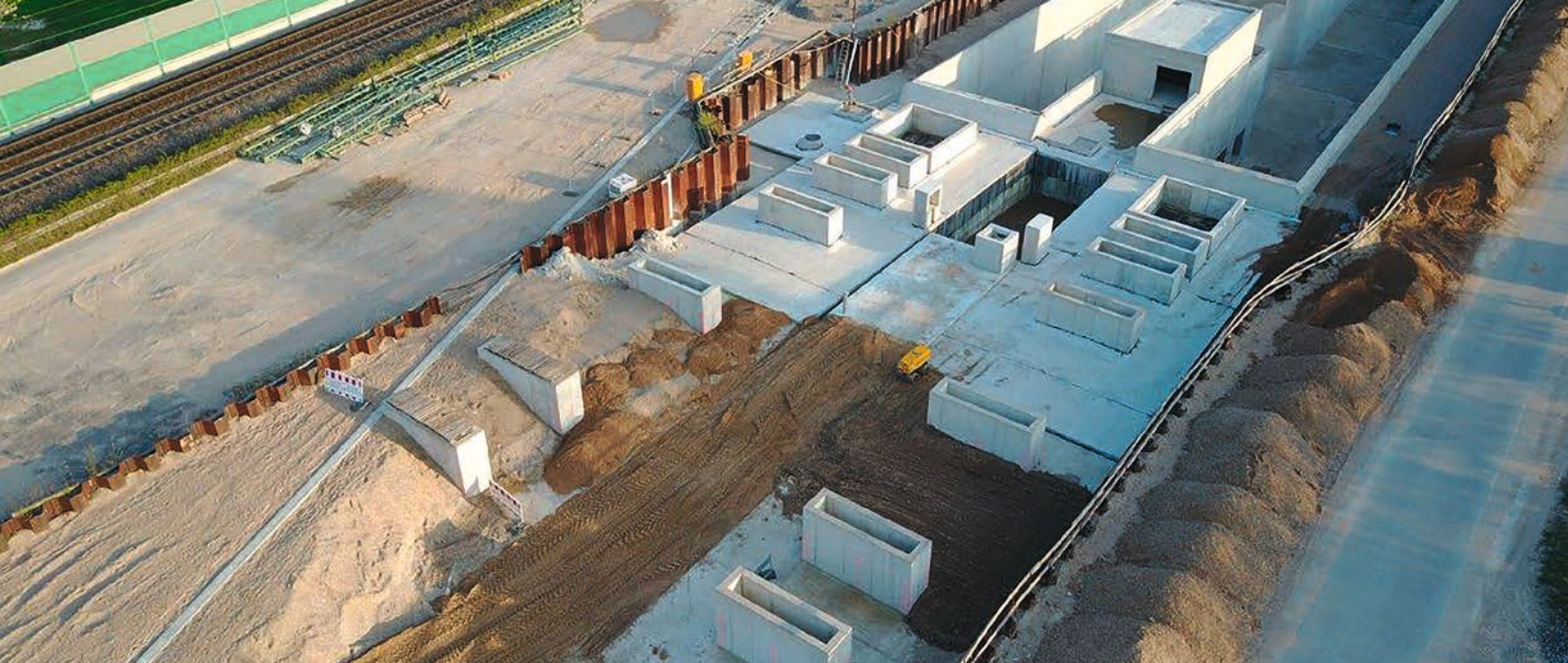
Blick auf die Sonic Boom-Bauwerke am südlichen Tunnelportal
