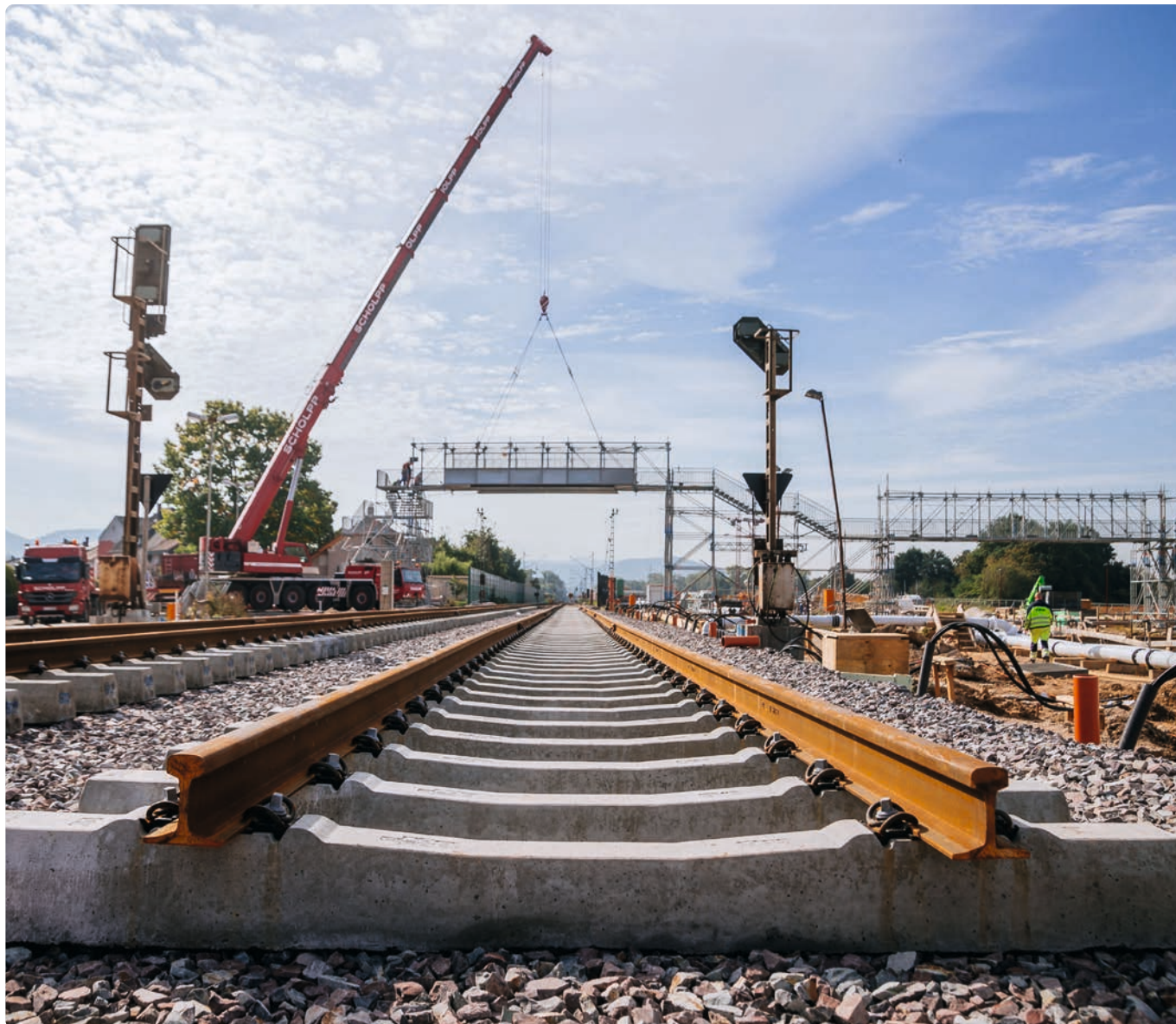
Die Gleise der Rheintalbahn wurden innerhalb weniger Wochen repariert. Am 2. Oktober 2017 konnten die Züge wieder fahren.
