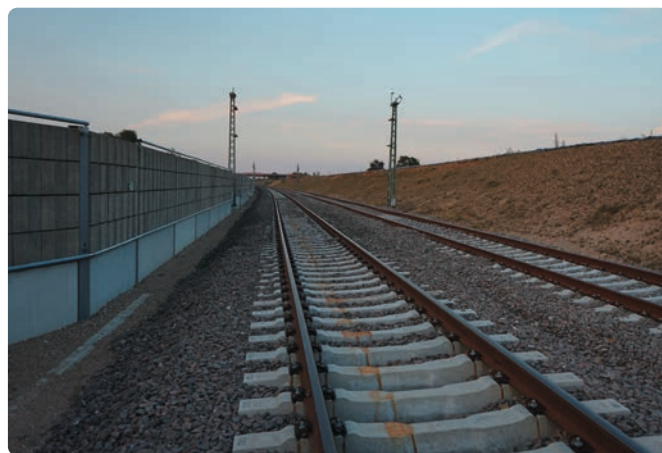
Schallschutzwände an der Neubaustrecke Bashaide–Ötigheim
