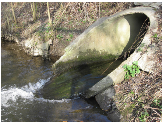
Abb. 14: Einmündung (Rohrdurchlass) des Landwasserbachs in den Mühlbach. Hier ist eine Krebschutteinrichtung erforderlich. Die Situation am Kuhlagerbächle gleicht der am Landwasserbach (Foto Pfeiffer)
