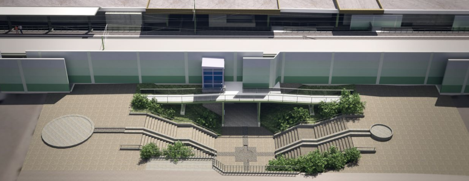
Der Fußgängersteg zum Aufzug wird auf 1,60 Meter verbreitert.
