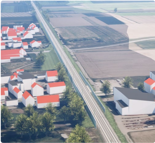
Entlang von Tunsel kommen neue Schallschutzwände hinzu, die die Anwohnenden von Lärm entlasten.
