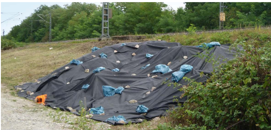
Vergrämgung von Reptilien: Die gemähte Fläche wird mit Folie ausgelegt.
