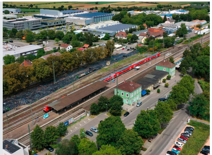
Der Bahnhof Müllheim in seinem jetzigen Zustand
