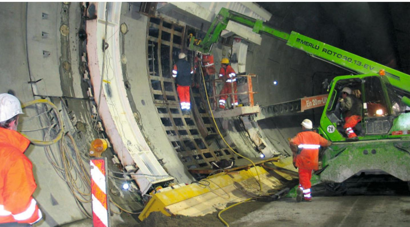
Für den Bau der Verbindungsbauwerke werden Spezialtübbinge aus Stahl verwendet
