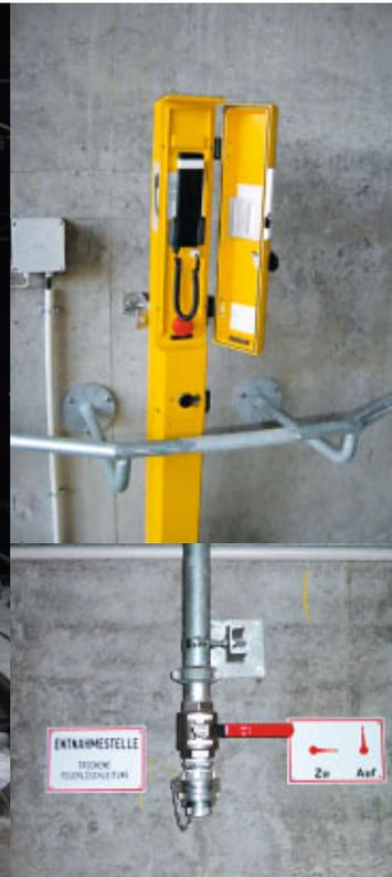
In der letzten Bauphase erfolgt der Einbau von Sicherheits- und Versorgungseinrichtungen wie Notrufsäulen und Löschwasserentnahmestellen
