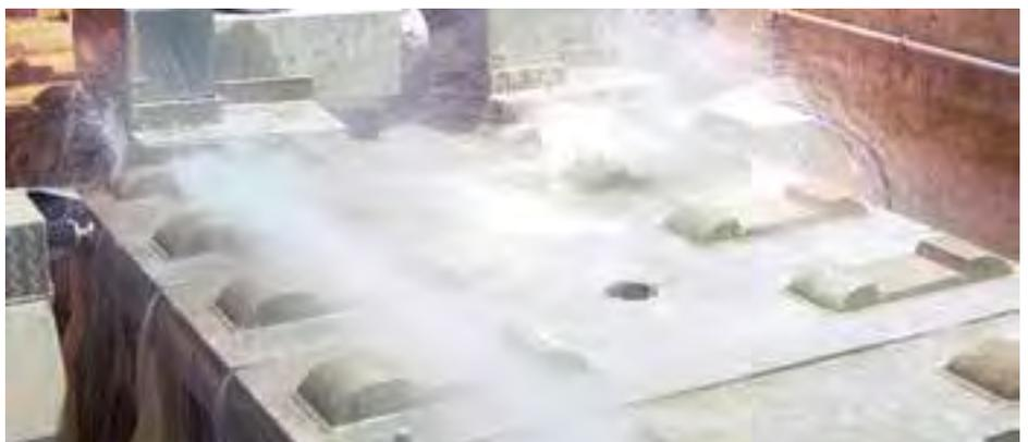
Millimetergenaue Auflagerflächen für die Schienenbefestigung dank computergesteuerter Schleifmaschine
