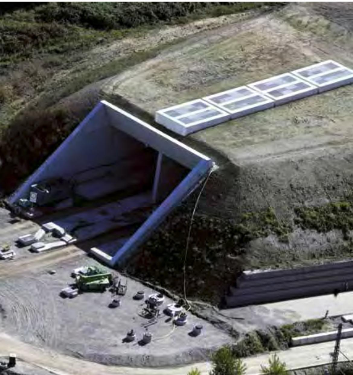
... als auch die oberen Öffnungen des Haubenbauwerks ermöglichen den Druckausgleich.
