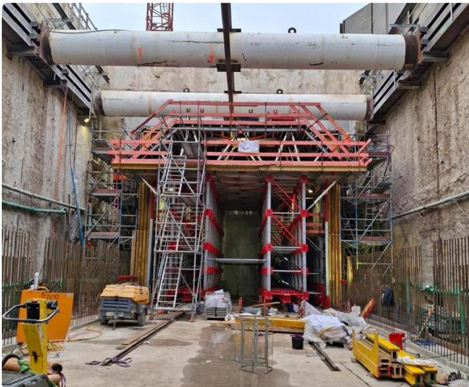
Mithilfe des Schalungswagens entstehen die Seitenwände und Decken.
