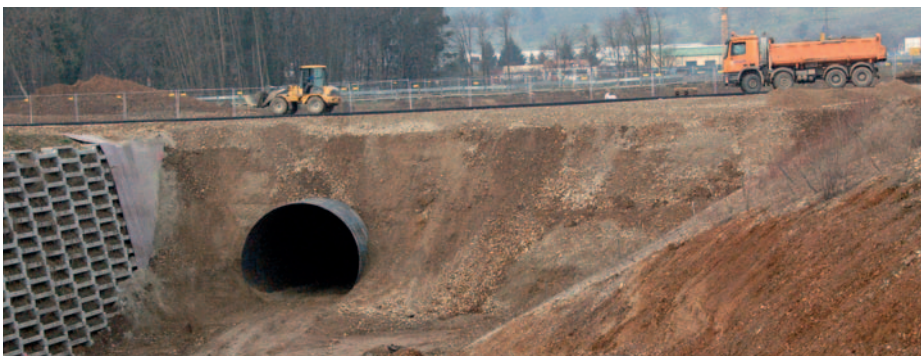
Trassenbaustelle im Bereich der Landesstraße L 137
