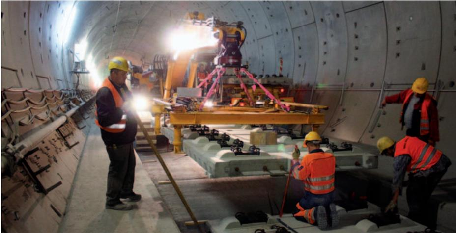
In der Weströhre des Katzenbergtunnels hat Ende Mai 2011 der Einbau der Festen Fahrbahn begonnen. Bei diesem innovativen Fahrweg liegen die Gleise in einem Betonbett und brauchen weder Schwellen noch Schotter.
