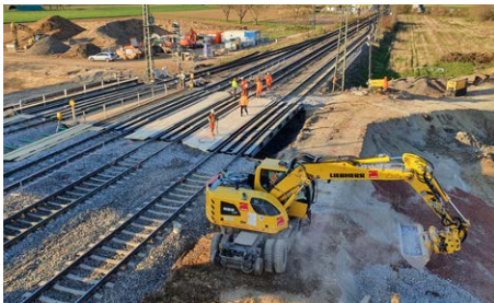
An der EÜ Zienkener Weg wurden die Hilfsbrücken eingebaut.
