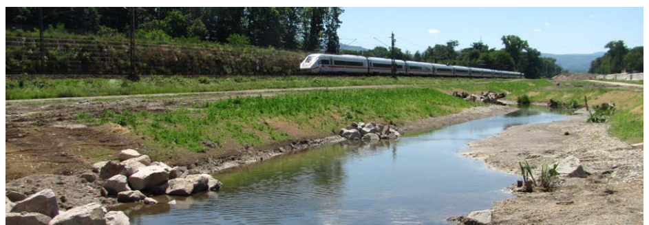
Der neue Bachlauf des Ooser Landgrabens
