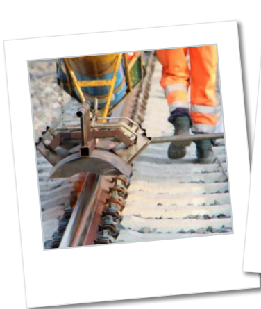
Westliche Gleistrasse in Betrieb
