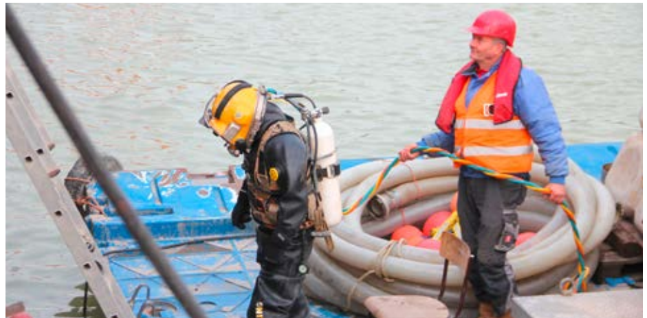
Ein Taucher bereitet sich auf seinen Unterwassereinsatz an der Grundwasserwanne Nord vor.
