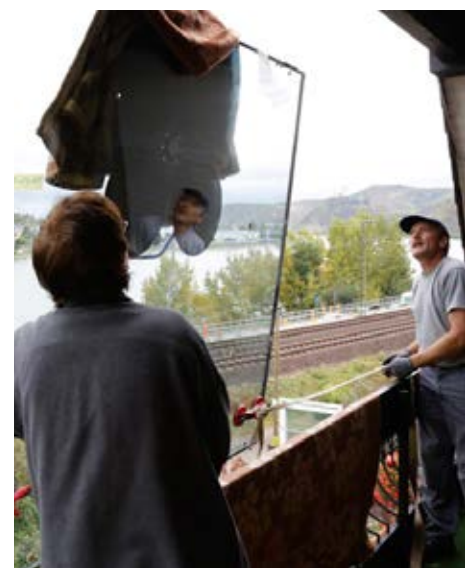
Einbau eines Schallschutzfensters
