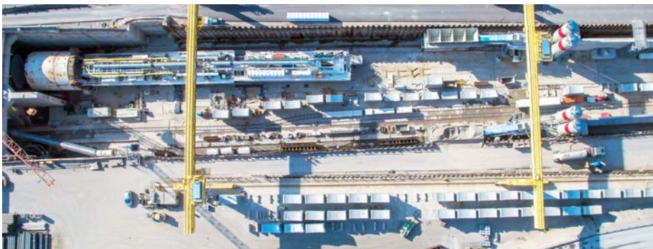
Blick in die Vergangenheit: Sibylla-Augusta wird in der Startbaugrube montiert.
