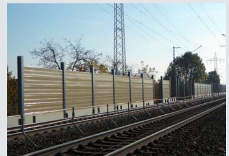
Neue Schallschutzwand in Otterbach
