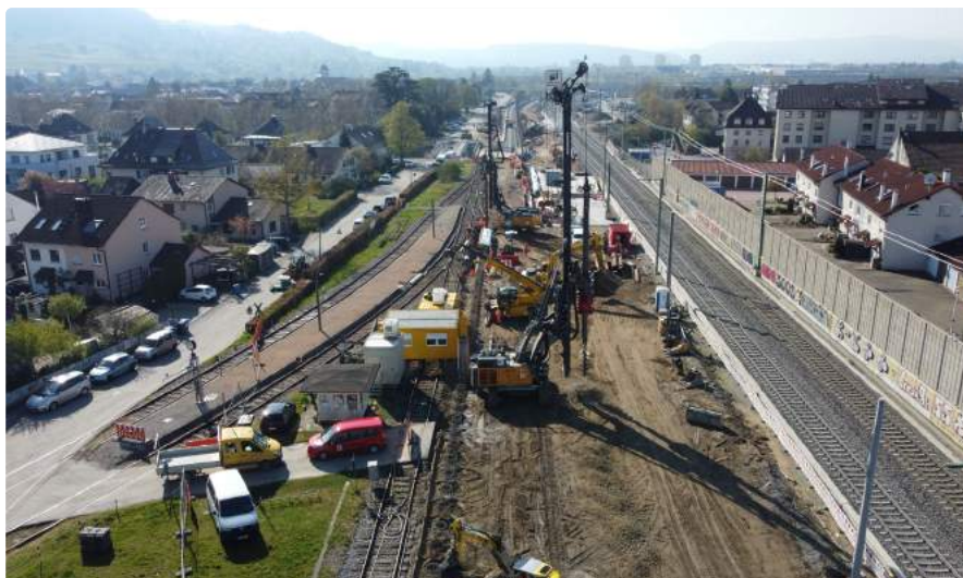
Blickrichtung Süd: Bohrung von Pfählen
