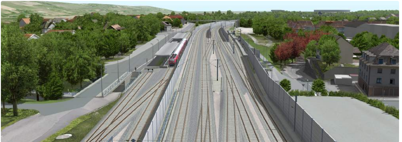
Verbindung der westlichen und östlichen Betonträge im Bereich der Eisenbahnüberführung Heldelinger Straße
