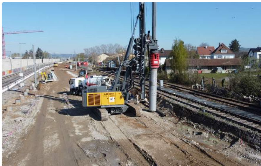
Bohrpfahlgerät im Einsatz
