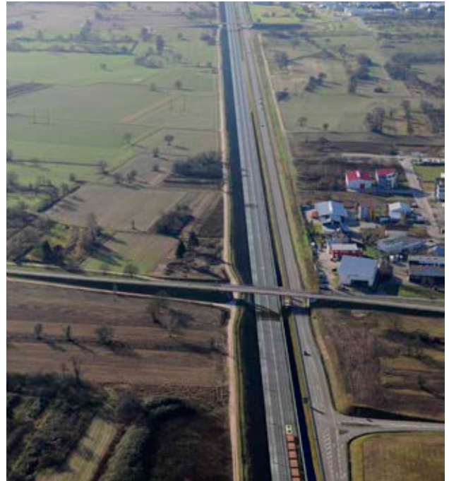
Parallellage der Neubaustrecke mit der Bundesstraße 36, Blick Richtung Süden
