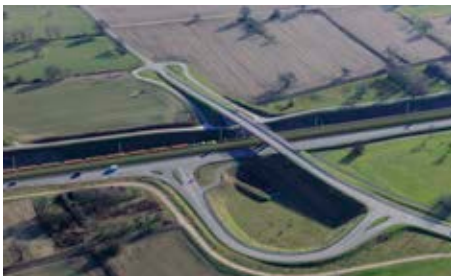
Straßenüberführung über der Bundesstraße 36 und der Neubaustrecke bei Bietigheim
