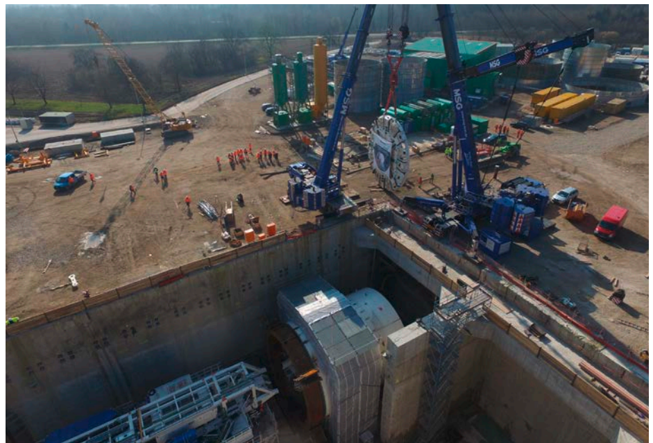
Die erste TVM in der Startbaugrube: Das Schneidrad wird eingesetzt.
