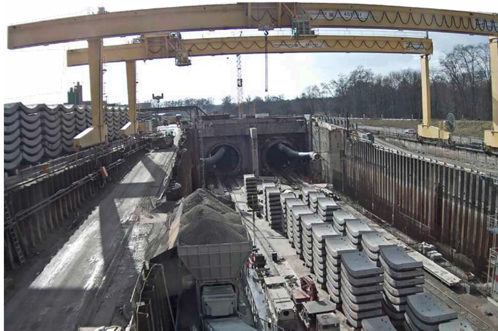
Der Blick der neuen Webcam direkt auf das Tunnelportal in Ötigheim.
