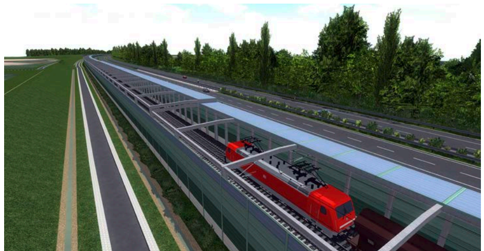
Galeriebauwerke mindern den Lärm direkt an der Quelle. Im PfA 8.1 werden sie auf insgesamt 2,6 Kilometer Länge errichtet.
