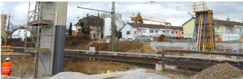
Die Fußgängerbrücke in Haltingen nimmt Formen an.
