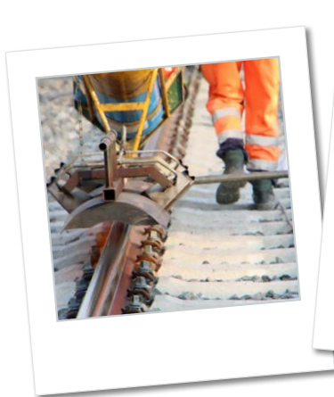
Westliche Gleistrasse in Betrieb
