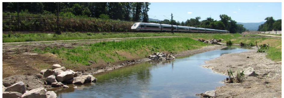
Der neue Bachlauf des Ooser Landgrabens
