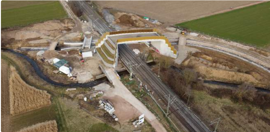
Das neue Flussbett der Hügelleheimer Runs entsteht.
