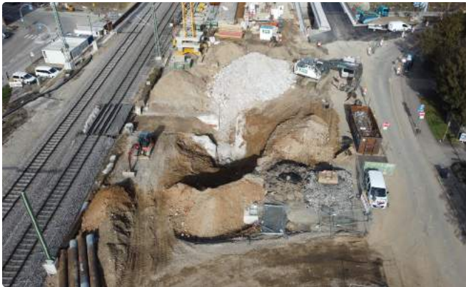
Die Fußgängerunterführung macht Platz für die Fernverkehrsgleise.
