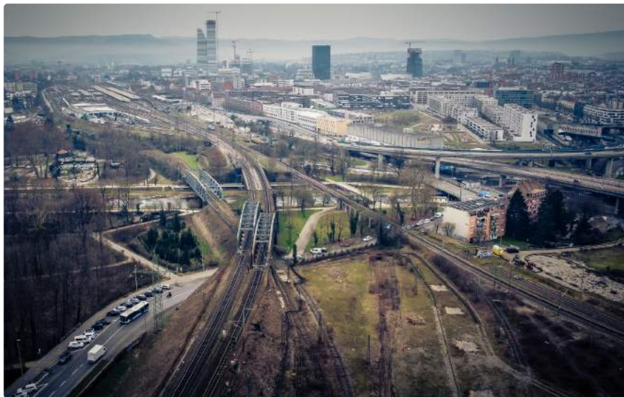
Die Bahn erneuert die bestehenden Eisenbahnbrücken.
