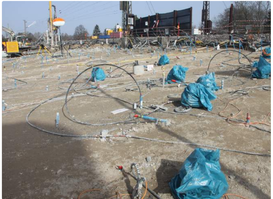
Einige Injektionslanzen sind bereits im Boden.
