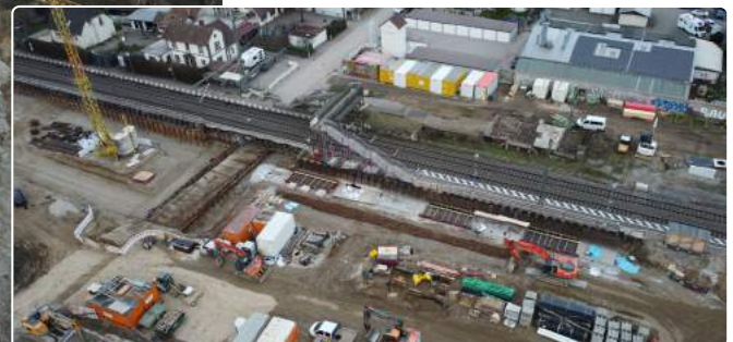
Die neue Personenunterführung am Haltepunkt Auggen befindet sich im Bau.
