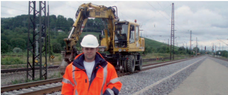
Bauüberwacher Torsten Haas in „seinem“ Abschnitt nördlich des Katzenbergtunnels
