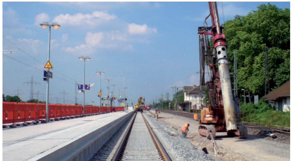
Neue Gleise und neuer Mittelbahnsteig in Schliengen
