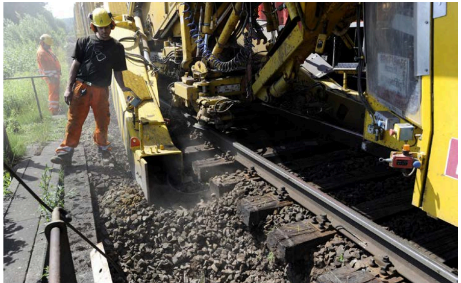
Zwischen Schliengen und Haltingen werden in mehreren Bereichen die Gleise saniert
