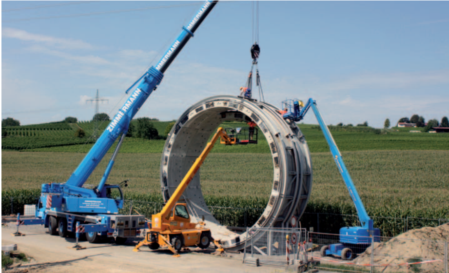
In nur vier Wochen wurden die Tübbingelemente aufgestellt ...
