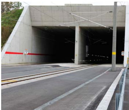
Bei einem zweiröhrigen Tunnel hat jede Fahrtrichtung ihre eigene Röhre (hier: Katzenbergtunnel).
