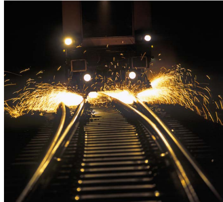
Das BüG wird als aktive Schallschutzmaßnahme eingesetzt.
