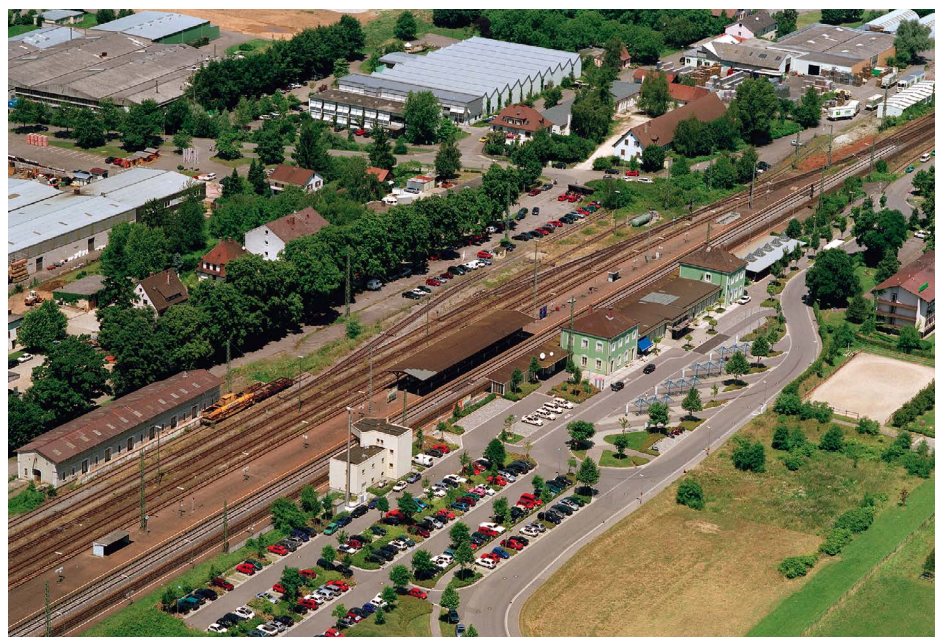
Der Müllheimer Bahnhof bekommt ein neues Empfangsgebäude, einen neuen Vorplatz und barrierefreie Zugänge zu den Bahnsteigen.
