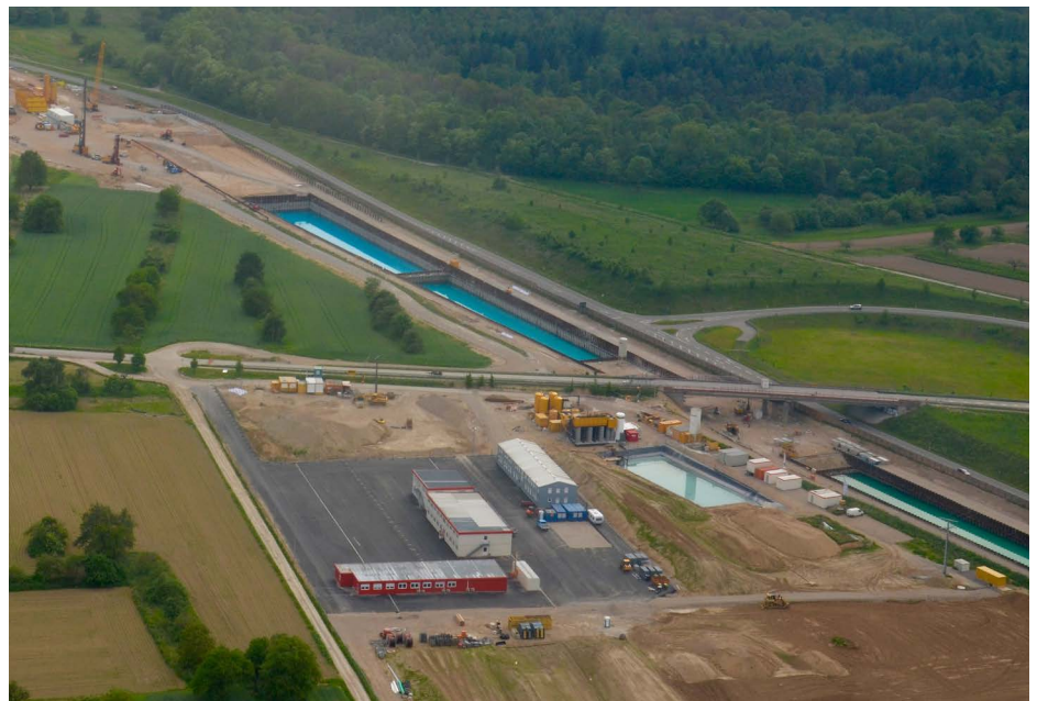
Das Info-Center (rotes Gebäude) befindet sich auf der Baustelleneinrichtungsfläche in Ötigheim.
