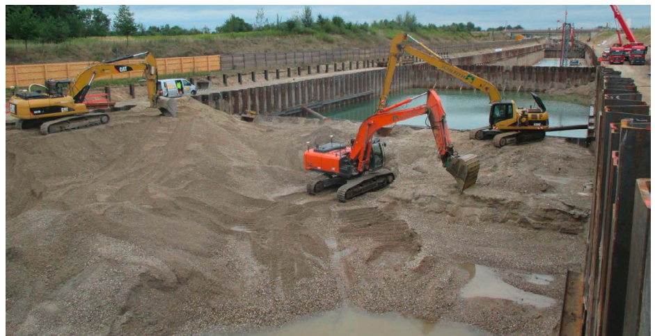
Aktuell wird in Ötigheim die Startbaugrube für den Tunnelvortrieb vorbereitet.
