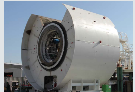
Die TVM nimmt Formen an, hier im September 2015.
