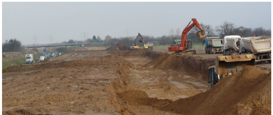
Die Baugrube verläuft parallel zur Bundesstraße 36.
