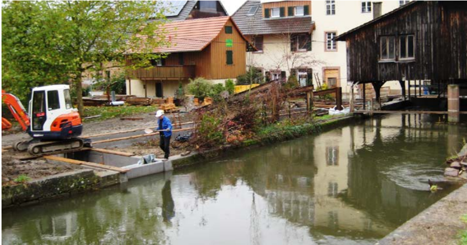
Im Herbst begannen die Arbeiten an der Fischtreppe.
