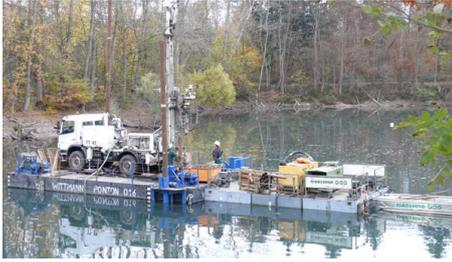
einem ersten Bohrprogramm bereits die Bodenverhältnisse zwischen Appenweier und Hohberg untersucht. Im Bereich des Offenburger Bürgerwaldsees entnimmt eine Bohrmannschaft bis zum Jahresende 2018 Proben aus 30 bis 42 Metern Tiefe. Das Besondere daran: Sieben von elf Bohrungen fanden unmittelbar auf dem See statt. Die Ausschreibung für die zweite Stufe des Bohrprogramms wird
