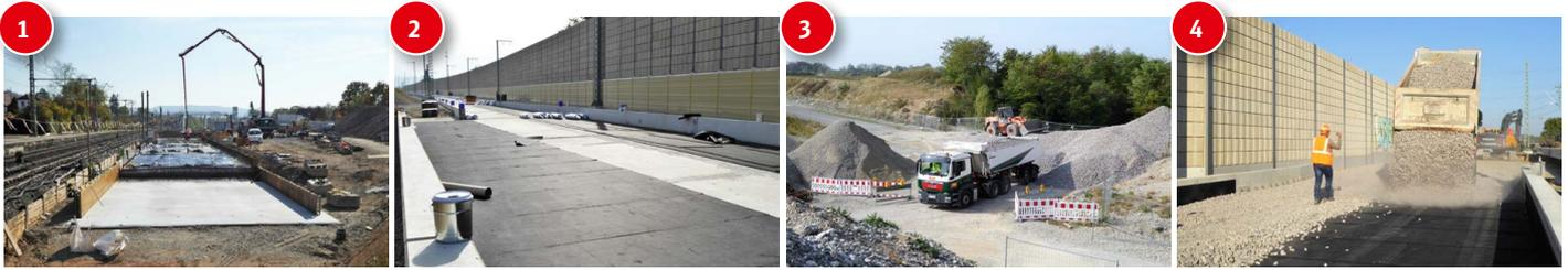
**1** Zuerst wird die sogenannte Bewehrung aus Bewehrungsstahl hergestellt, im Anschluss erfolgt die Betonage.
