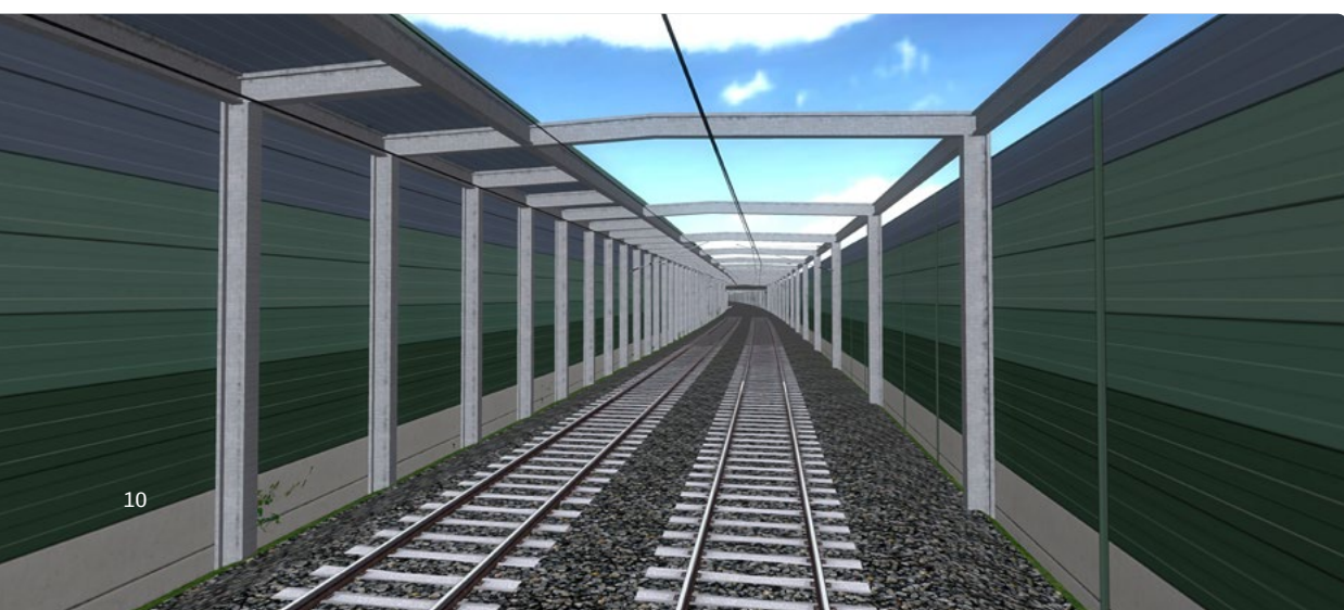
Neben Schallschutzwänden werden im Pfa 8.1 zusätzlich Galeriebauwerke realisiert.
