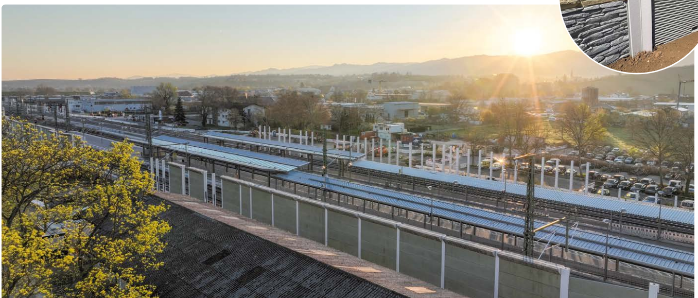
Schallschutzwände am Bahnhof Müllheim
