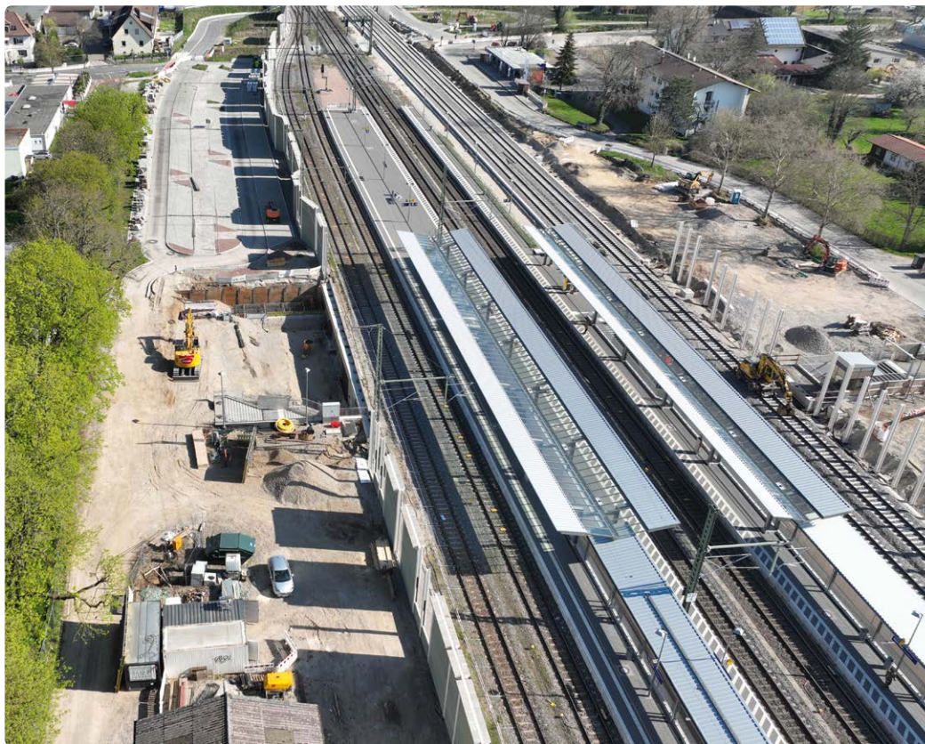
Bahnhof Müllheim: zwei neue Gleise, überdachte Bahnsteige und windgeschützte Zugänge
