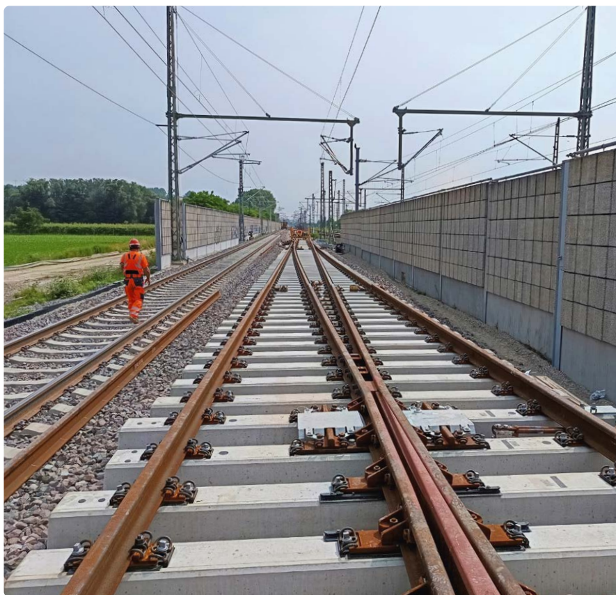
Fertigstellung der Neubaustrecke in den letzten Zügen
