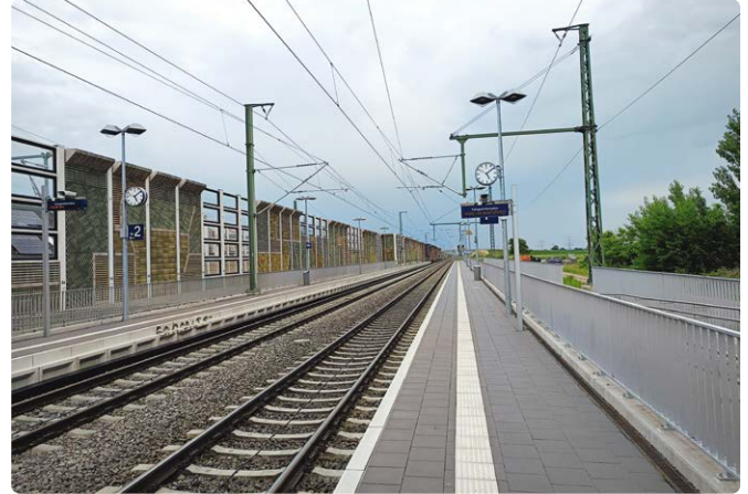
...zur Umsetzung: die westliche Schallschutzwand am Haltepunkt Auggen
