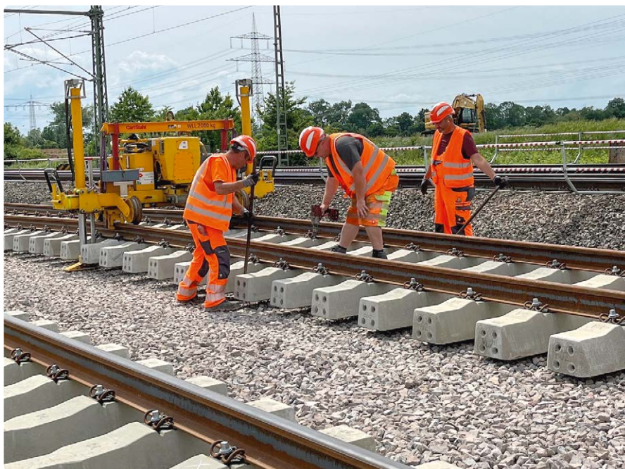
Gleisbauer im Einsatz an der Neubaustrecke
