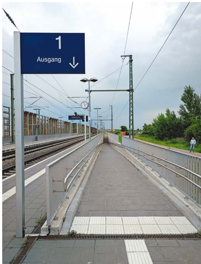
Barrierefreie Rampen führen zu den Bahnsteigen.
