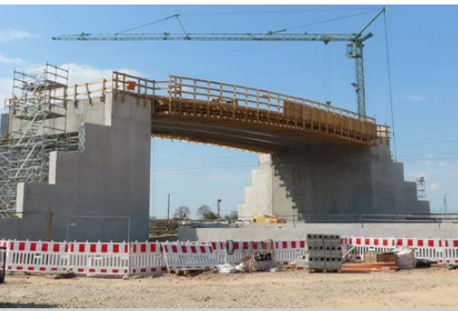
Der Überbau ist bereits betonierte. Nun folgen die seitlichen Leitstrukturen.
