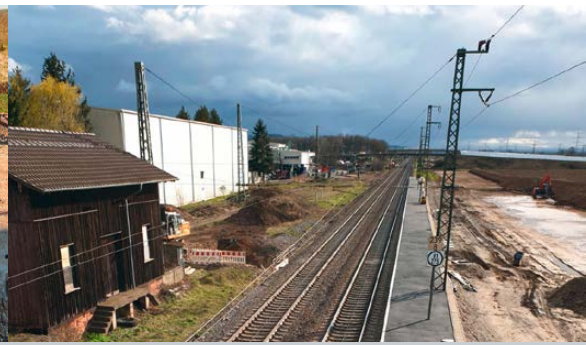
Am Haltepunkt Auggen entstehen temporäre Behelfsbahnsteige.
