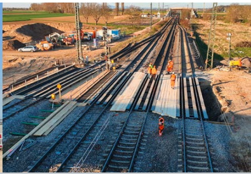
Der Bau der neuen EÜ Zienkner Weg hat begonnen.
