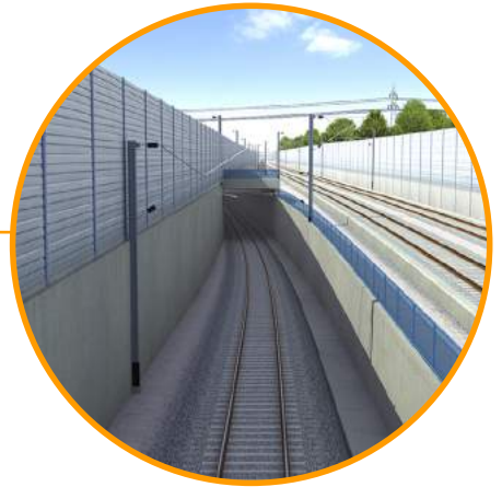
Eine Rampe mit seitlichen Stützwänden führt aus dem Überwerfungsbauwerk heraus.
