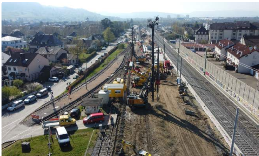
Blickrichtung Süd: Bohrung von Pfählen
