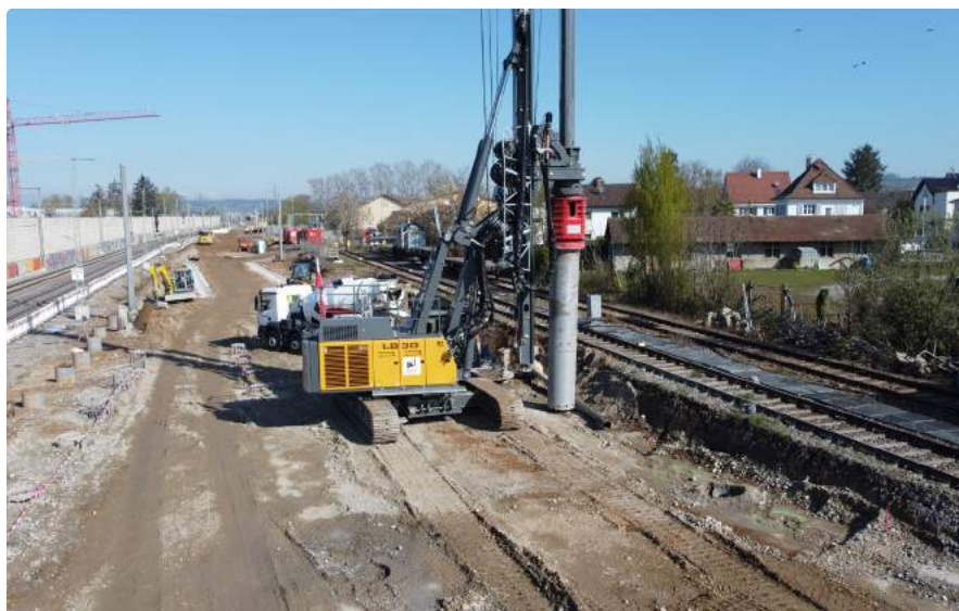
Bohrpfahlgerät im Einsatz
