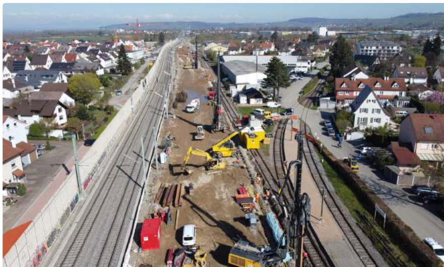
Blickrichtung Nord: Das Baufeld für das ÜBW und die östliche Gleistrasse ist freigemacht.
