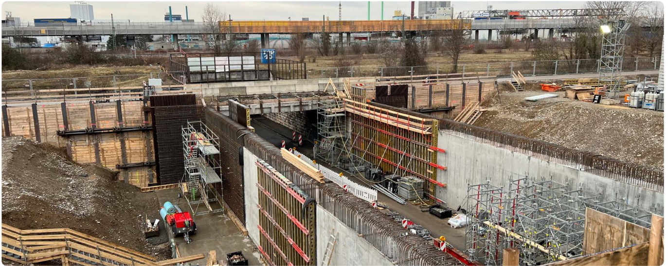
EÜ Neuhausstrasse während der Bauarbeiten
