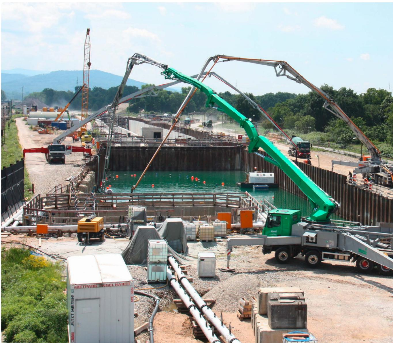
Um die Grundwasserwannen zu errichten, legte die Bahn Baugruben an. Aus ihnen konnte das Grundwasser dann abgepumpt werden.
