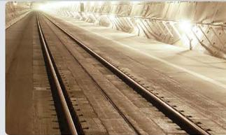
Die Feste Fahrbahn in beiden Röhren kann mit normalen Straßenfahrzeugen befahren werden. Die Rettungskräfte gelangen somit schnell an ihren Einsatzort.
