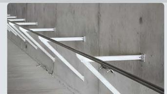
Als zusätzliche Hilfe werden auf einer Höhe von etwa einem Meter Handläufe entlang der Fluchtwege angebracht.
