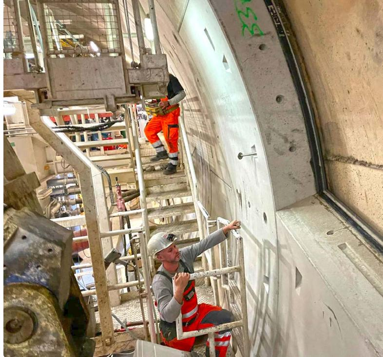
Während des Vortriebs wird die Innenwand des Tunnels mit Tübbing verschalt.
