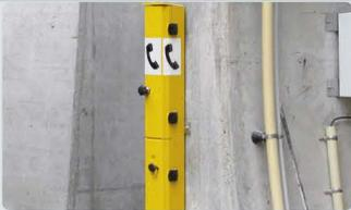
Notrufsäulen an den Tunnelportalen und den Querverbindungen im Tunnel gewährleisten die Kommunikation zwischen Fahrgästen und Rettungskräften.
