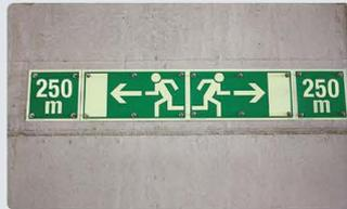
Piktogramme und Richtungspfeile weisen zum nächstgelegenen sicheren Bereich. Die maximale Entfernung dorthin beträgt 250 Meter.
