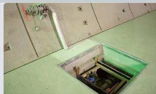
Alle 125 Meter sind Löschwasserentnahmestellen im Tunnel angebracht. Sie können mit 800 Liter Wasser pro Minute versorgt werden.
